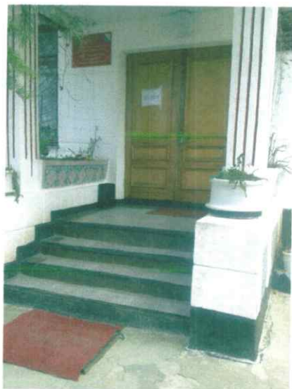
2а Вход (входы) в здание
